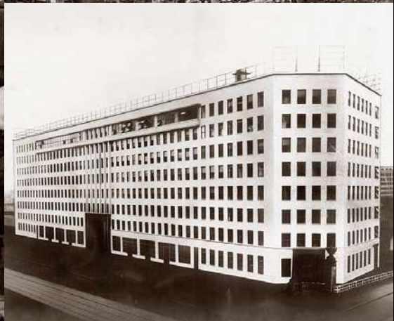
未だ荒涼とした首都で始まった基礎工事/資金・労力不足に加え、外濠を埋め立てた土地という多くの困難を乗り越えながら進む工事/戦後初の高層ビルとして完成した第一鉄鋼ビルディング
