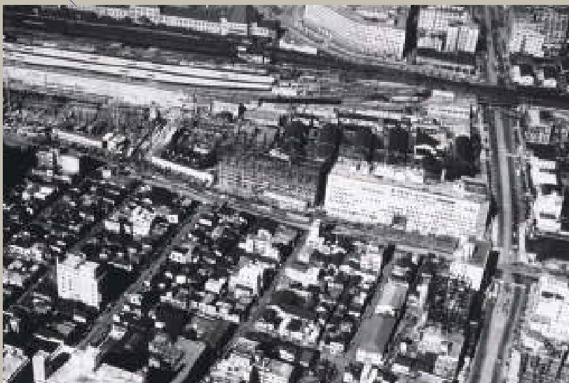
第二鉄鋼ビルディング工事中（昭和28年）
