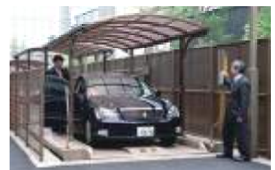
第二鉄鋼ビル西側・立体駐車場 21台収容可能
