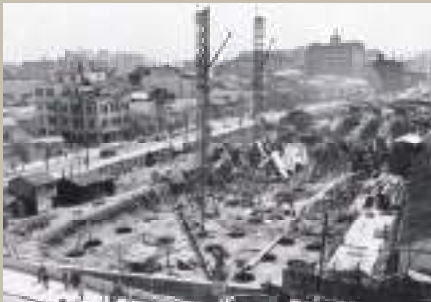
第一鉄鋼ビルディング基礎工事
