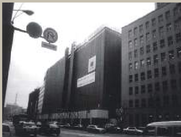
第二鉄鋼ビルディング外壁工事中
