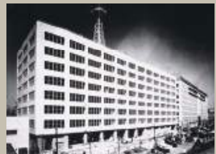
完成目の第二鉄鋼ビルディング
