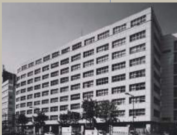
第二鉄鋼ビルディング外壁工事完了
